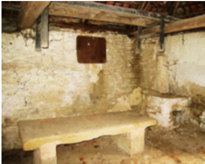
Taharahaus in Ermetzhofen (Lk. Neustadt/Aisch-Bad Windsheim) mit Steintisch, Herdstelle und Bahre (im Dachgebälk). Foto: E. Schultheiß
